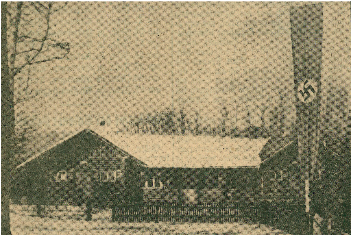
Abb. 26: Pressefotografie der neuen Schießbahn im Rohrwang, Kocher-Zeitung vom 13. Februar 1939.
