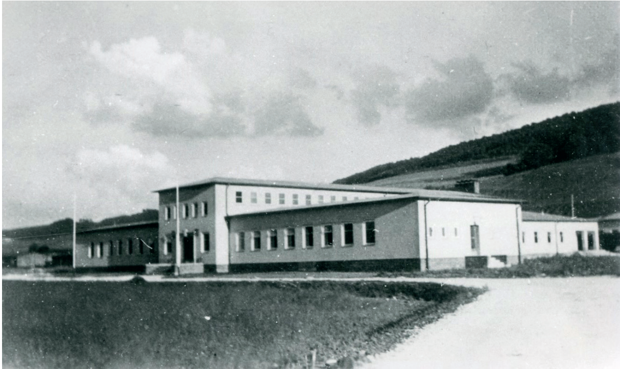
Abb. 35: Hinter dem Verwaltungsgebäude der Gutehoffnungshütte A.G. am Langert wurde der Faber-du-Faur-Stollen aufgeföhren, der weit nach Westen in den Langert hineinreichte.
