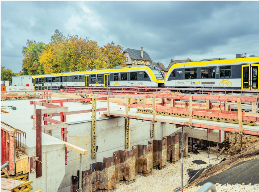
Das fast fertiggestellte Einschubbauwerk der Bahnüberführung.
