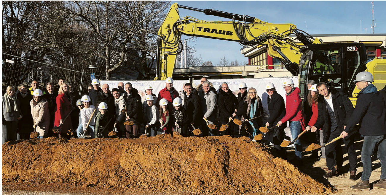
Zahlreiche Gäste waren zum Spatenstich der neuen Ganztagesbetreuung an der Greutschule gekommen.
