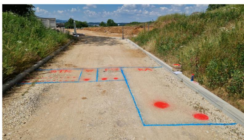
Schematische Darstellung der Rohr- und Leitungsverläufe.
