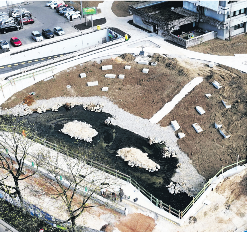
Bereits gut erkennbar sind die Sitzgelegenheiten und die landschaftliche Gestaltung des neuen Gaulbads. Foto: Stadt Aalen
