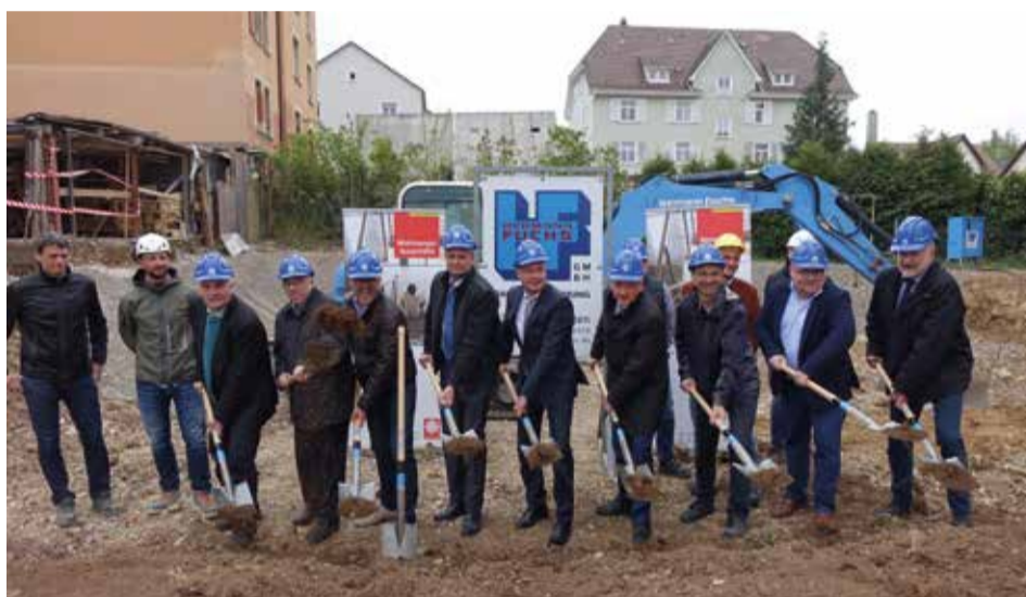
Spatenstich in der Düsseldorfer Straße für das Haus Klara
