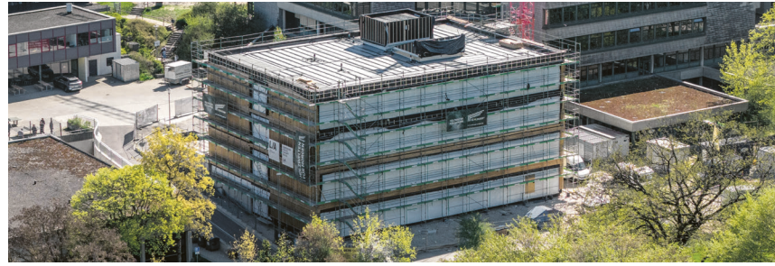
Der Neubau an der Karl-Kessler-Schule macht sichtbare Fortschritte. Foto: Stadt Aalen
