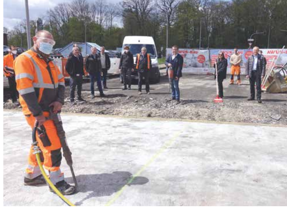
Erster Bürgermeister Wolfgang Steidle (Mi.) und Ortsvorsteherin Andrea Hatam starteten gemeinsam mit den Vertretern der am Bau beteiligten Firmen die Sanierung der Kocherbrücke. Foto: Stadt Aalen
