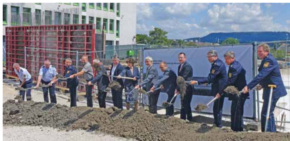
Spatenstich in der Böhmerwaldstraße.
