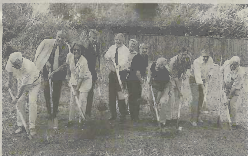
Erster Spatenstich für Dorfmühle II.
