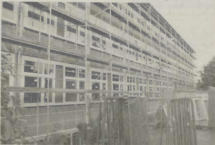
Die neuen Fenster in der Hermann-Hesse-Schule sind gesetzt. Die Fassade wird noch wärmeisoliert.
