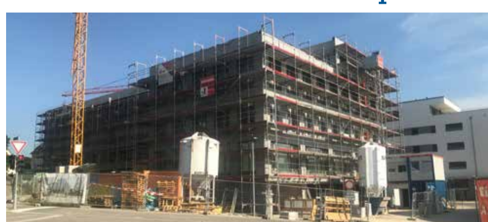
Weit gediehen ist der Bau des DRK mit integrierter Kita auf dem Stadtoval. Foto: Stadt Aalen
