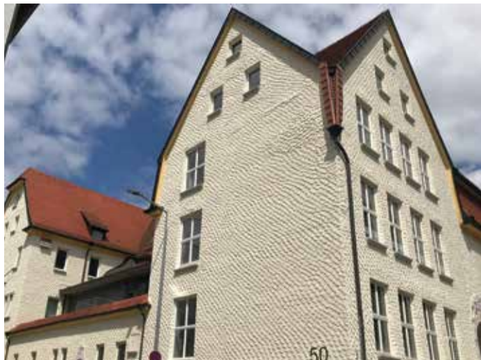
Der Kellenputz der Bohlschule wurde erneuert – das Gebäude war im Juli 2019 Denkmal des Monats.
