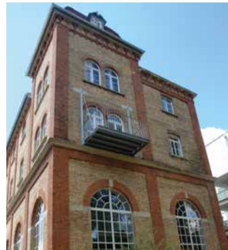
Das Sudhaus der Grünbaumbrauerei wurde zu Lofts umgestaltet.
