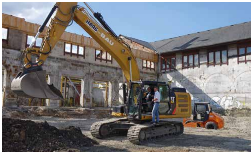
Oberbürgermeister Thilo Rentschler gibt den Startschuss für die Erschließungsarbeiten. Rechts: Simon Haag, Geschäftsführer der ausführenden Firma Haag aus Neuler. Foto: Stadt Aalen
