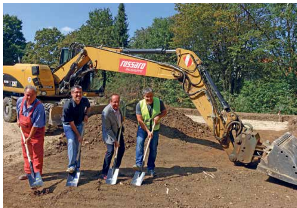
Bürgermeister Karl-Heinz Ehrmann (2. v. r.) gibt den Startschuss für den Bau der 67 weiteren Parkplätze. Foto: Stadt Aalen
