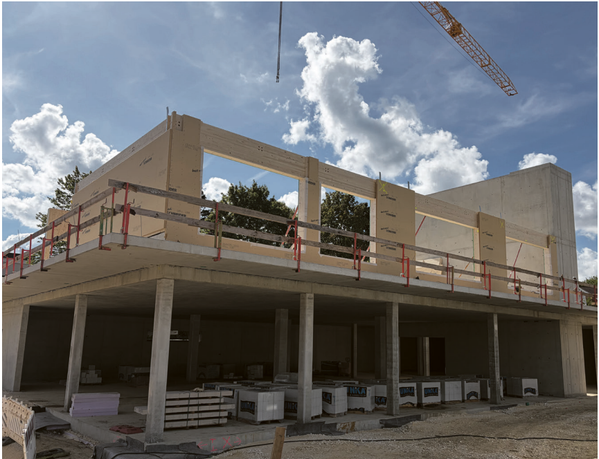
Das Untergeschoss, in dem die Mensa untergebracht wird und darüber die ersten montierten Holzbauteile. Foto: Stadt Aalen
