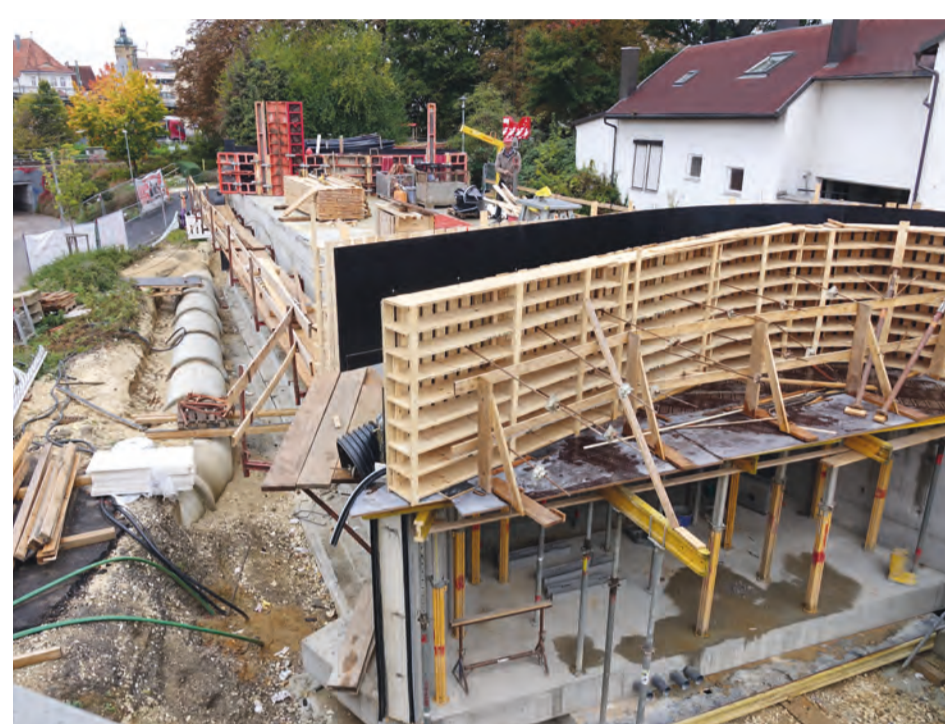
Die eigentliche Unterführung wurde vorgefertigt und wird während der Vollsperrung richtig positioniert.
