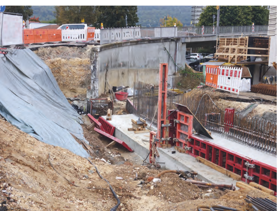
Die verlegten Stützwände der Hochbrücke werden vorbereitet.
