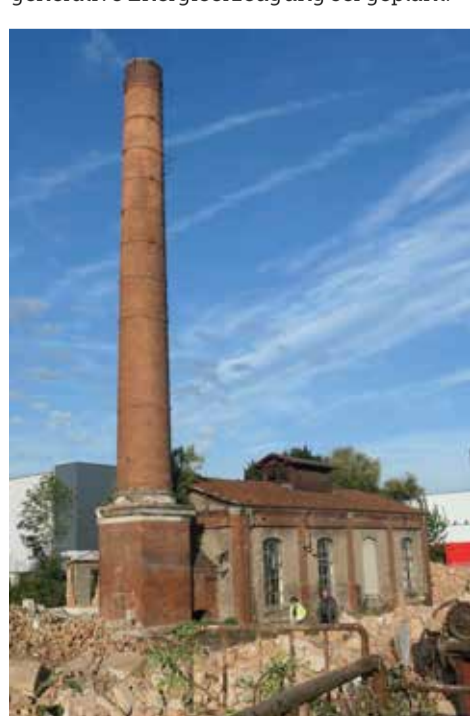
Das Dampfkesselhaus auf dem Union-Areal soll erhalten werden. Foto: Stadt Aalen
