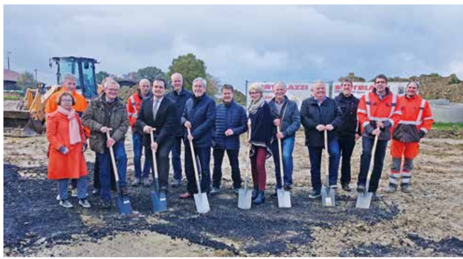
Erster Bürgermeister Wolfgang Steidle gab gemeinsam mit Ortsvorsteher Jürgen Opferkuch sowie Vertreterinnen und Vertretern des Fachsenfelder Ortschaftsrates, der Baufirmen und Mitarbeitern des Tiefbauamtes Aalen den Startschuss für das neue Baugebiet.
