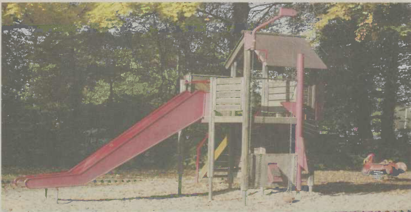
Der Kletterturm ist nach 20 Jahren nicht mehr sicher. Er wird durch eine neue Kletterkombination aus Robinienholz ersetzt.
