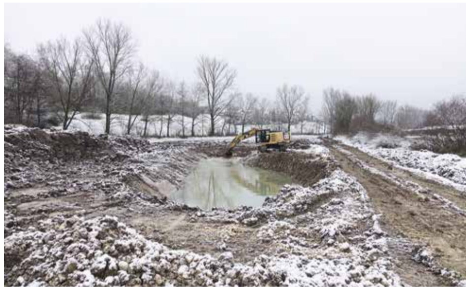
Baggerarbeiten am neuen Bachlauf.
