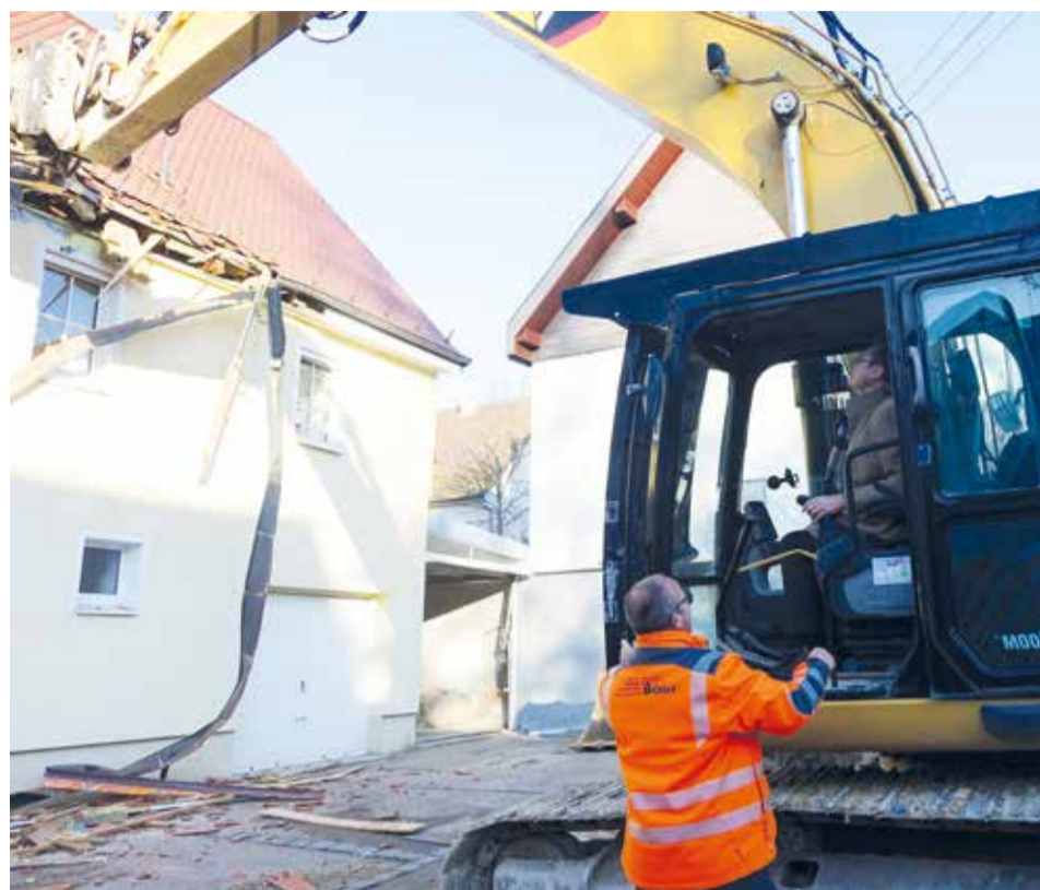
Mit dem Baggerbiss hat Oberbürgermeister Thilo Rentschler den Startschuss für die „Neue Mitte Dewangen“ gegeben.
