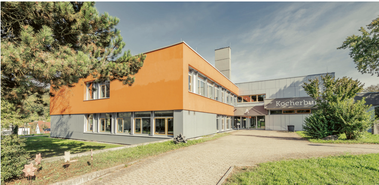
Die Kocherburgschule in Unterkochen wird nun mit Pellets beheizt.
