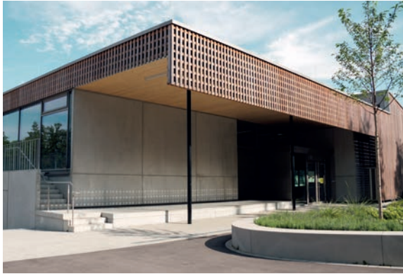
Die hohen Anforderungen an den neuen Fachklassentrakt...
