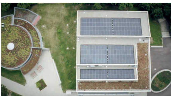
Die PV-Module liefern den benötigten Strom
