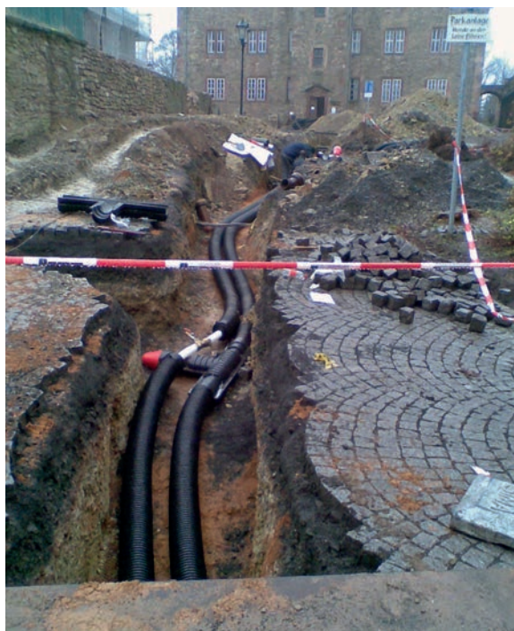
... bis zum Bau des neuen Nahwärmenetzes
