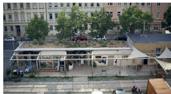
Pilotprojekt: So funktioniert Dachbegrünung
