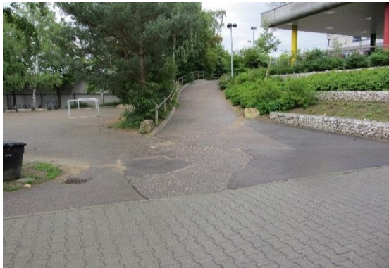
Belagsschäden im Bereich Realschule
