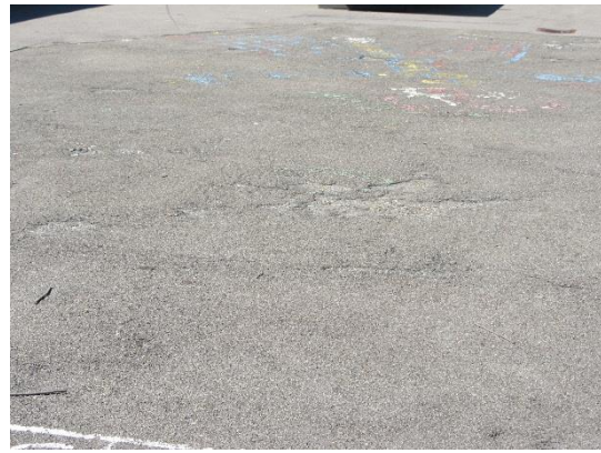
Schadstellen im Asphaltbelag
