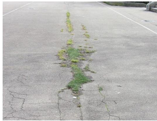
Belagsschäden Asphaltbelag
