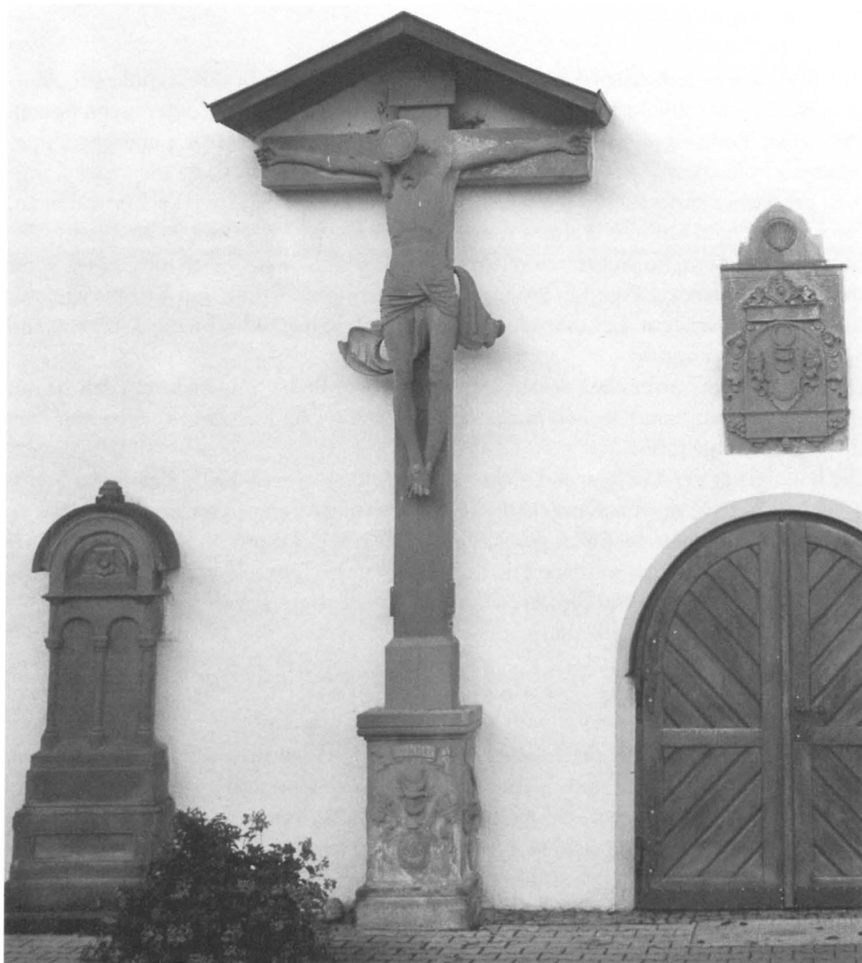
Eingangsbereich der evangelischen Kirche in Leinroden. Anders als in Fachsenfeld und Polsingen steht das Sandsteinkruzifix nicht hinter dem Altar, sondern an der Außenseite der Kirche.
