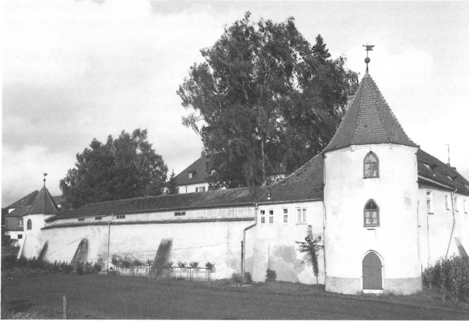
Polsingen, Schloßmauer mit Ecktürmen. Wahrscheinlich war die Anlage zu Zeiten Hans Sigmunds noch ein Wasserschloß.
