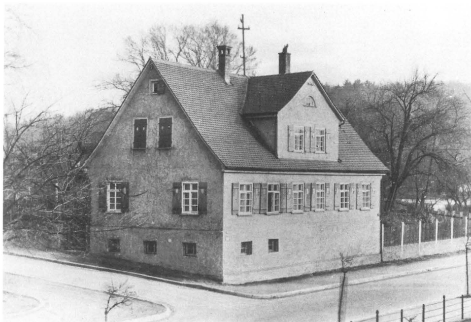
Erste evangelische Schule in Wasseraalfingen. In der ehemaligen Feinformerei, Ecke Wilhelmstraße/Erzweg, richtete das Königliche Hüttenwerk 1837 eine evangelische Volksschule ein. Dieses um 1816 erstellte Gebäude wurde 1956 abgebrochen.
