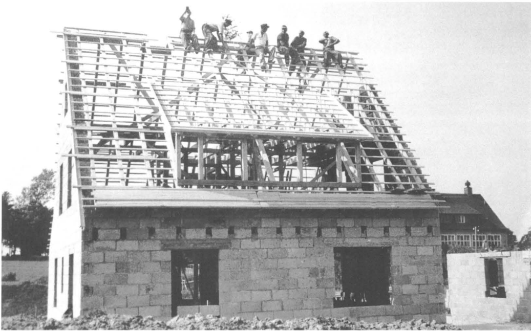
Der Rohbau des Siedlungshauses steht. Der Dachstuhl ist aufgerichtet. Das Richtfest kann gefeiert werden.
