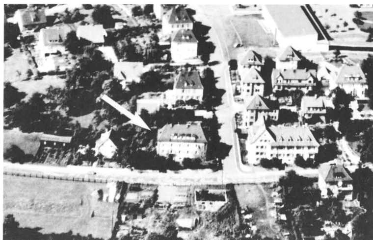
Blick auf den Neubau des Gesundheitsamtes Ecke Ziegel-/ Hauffstraße (Pfeil).
