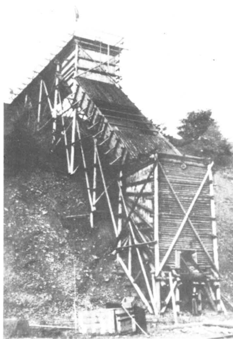
72 Erdrutsche vom Stollen „Tagstrecke Nr. 1“ zum „Tiefen Stollen“
