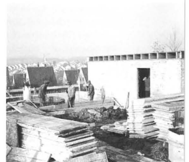
Die Sternwarte im Bau: Vortragsraum und Bibliothek.
