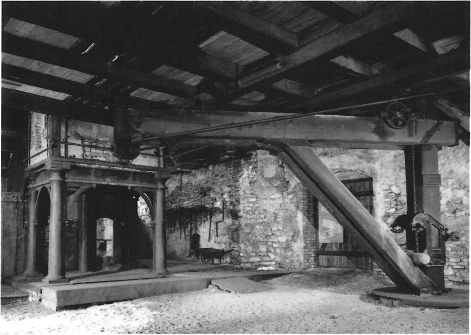
7 Alte Gießerei Königsbronn. Hölzerner Drehkran aus dem 19. Jahrhundert mit Laufkatze, Tragkraft 100 Zentner.
