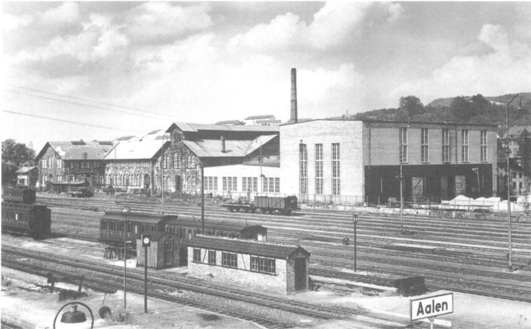
Das traditionsreiche Ausbesserungswerk Aalen kurz nach der Schließung 1955. Ganz links das kleine Portierhaus, daneben Flügel 1 (Verwaltung und Lager), Flügel 2 (Dreherei), Flügel 3 (Kesselschmiede) und das Neubaugebäude der Lokrichthalle (erstellt 1948). Flügel 1 bis 3 sind die ältesten in Aalen vorhandenen noch fast im Originalzustand erhaltenen Bahngebäude.
