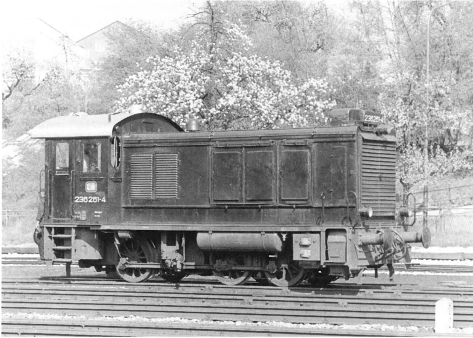
Eine „Wehrmachtslokomotive“ der Reihe V 36 (Computerbezeichnung 236 261 – 4) beim Rangieren im Bahnhof Aalen. Diese Maschine war eine Nachbestellung aus dem Jahre 1948. Unten rechts der Kilometerstein 0,2 der Brenzbahnstrecke.
