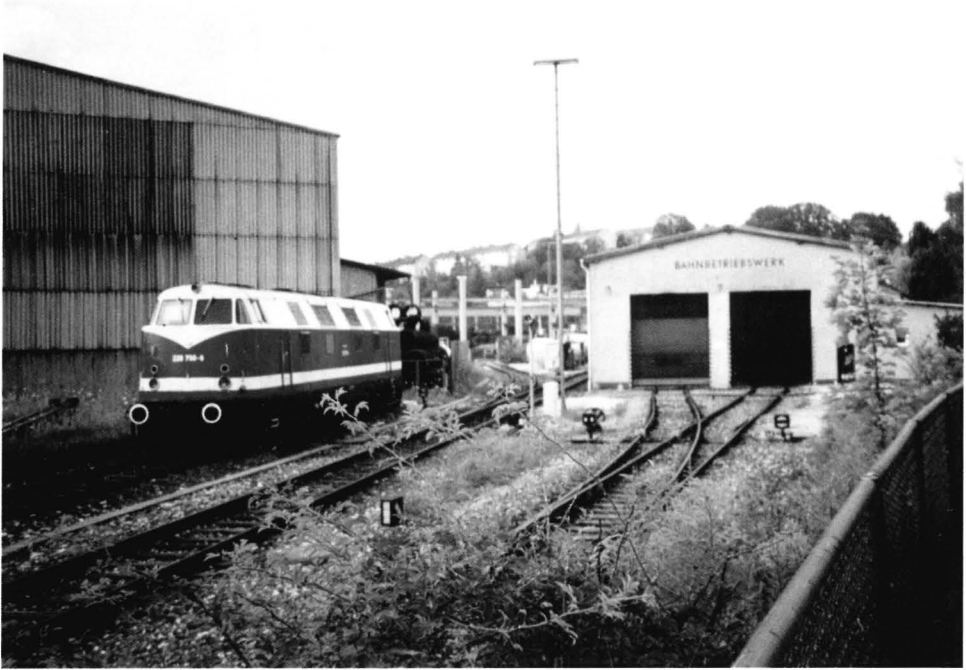
Vom Bahnbetriebswerk Aalen sind nur die zweigleisige Fahrzeughalle, einst in erster Linie für kleinere Motorschienenfahrzeuge gebaut, und einige Dienst- und Werkräume übrig geblieben. Links im Bild eine dieselhydraulische Lokomotive der Deutschen Reichsbahn bei einem Besuch Mitte 1993 in Aalen; die DR-Lok ist maschinenmäßig ähnlich der ehemaligen DB-Lok V 200. Im Hintergrund das ehemalige Freigelände des Bw Aalen, heute Lagerplatz der Firma Baustahlgewebe.
