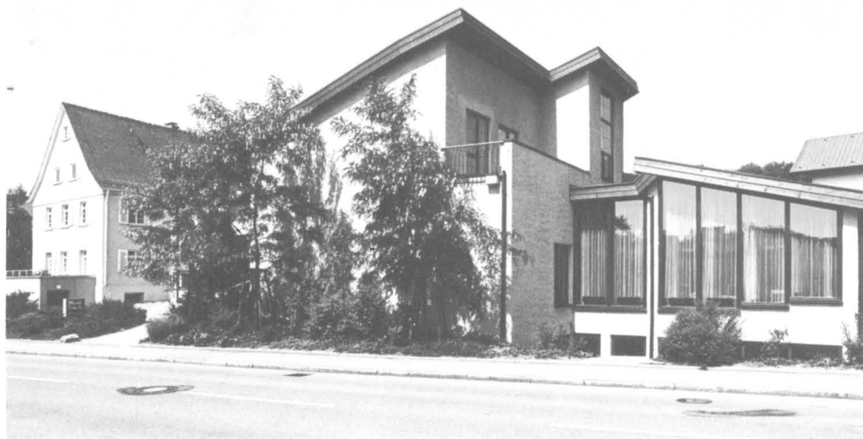
109 Der 1982 fertiggestellte Erweiterungsbau der Städtischen Musikschule an der Hegelstraße
