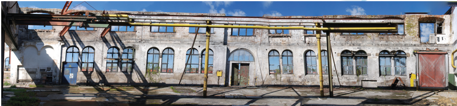
Blick in die Überreste des ehemaligen Bahnausbesserungswerks in Richtung der Bahngleise.
